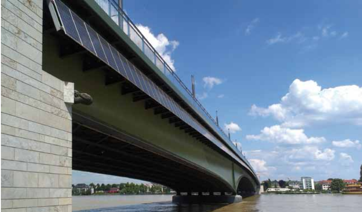
Die Stadt hat viele Flächen zum Sammeln von Energie: PV-Installation an der Bonner Kennedybrücke macht Strom für 20 Haushalte.
