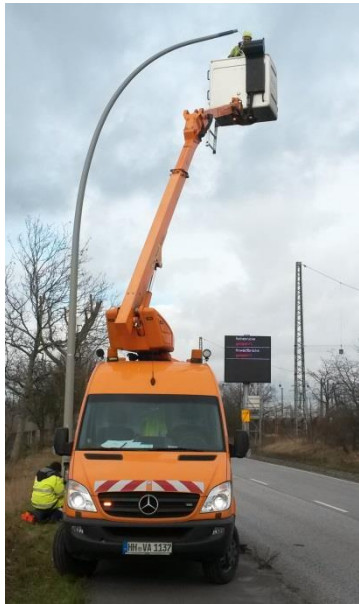
Montage der neuen Leuchten
